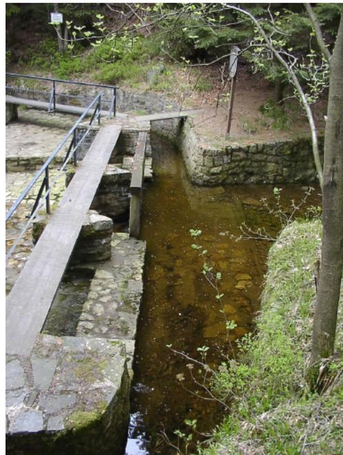
Abb 2. Der Fehlschlag „Große Söse“ fängt das Wasser des Wildbaches auf und leitet es in den Morgenbrodstaler Graben um.
